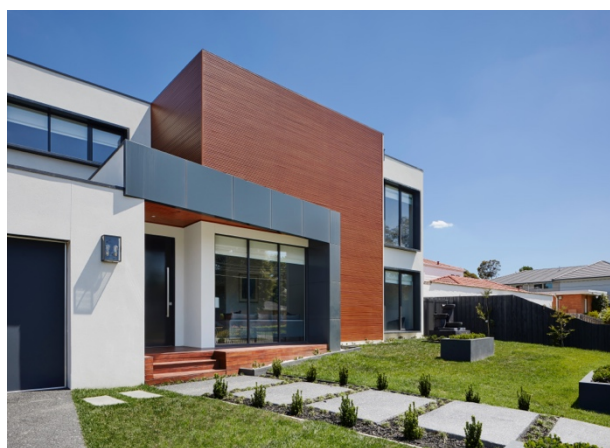
Frente del edificio (fuente: Google Street view)
